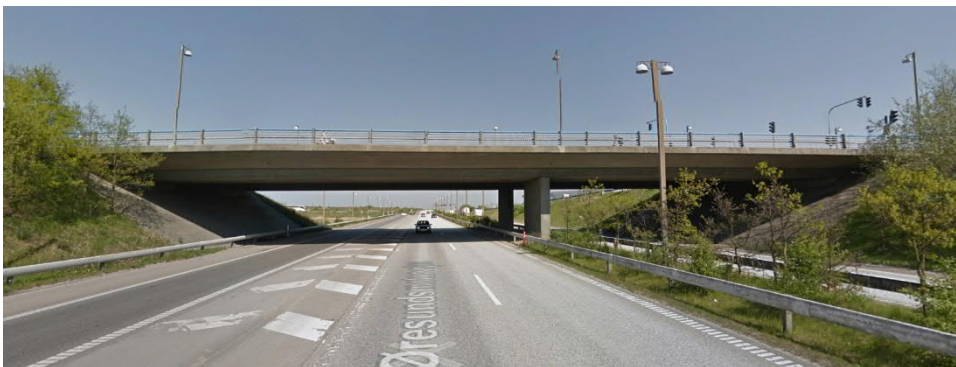
Figur 58: Foto, facade set mod øst.
