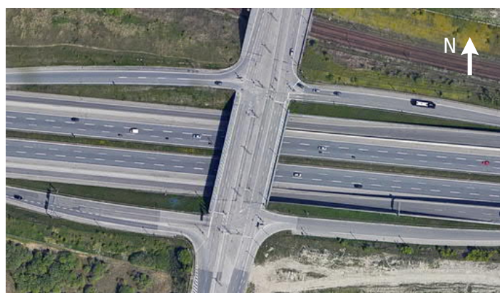
Figur 28 – Bro 10190 Center Boulevard, Luftfoto
