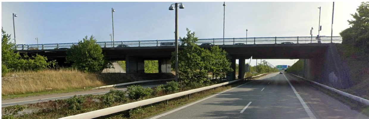
Figur 50 – Bro G10310 Amager Landevej, facade set mod øst.
