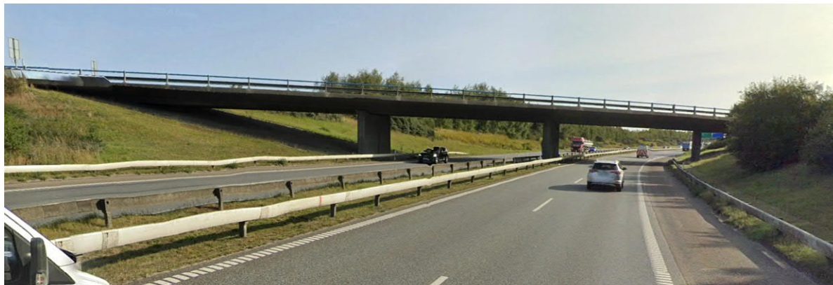
Figur 17 – Bro E10160 Rampe over Øresundsmotorvejen, facade set mod øst.
