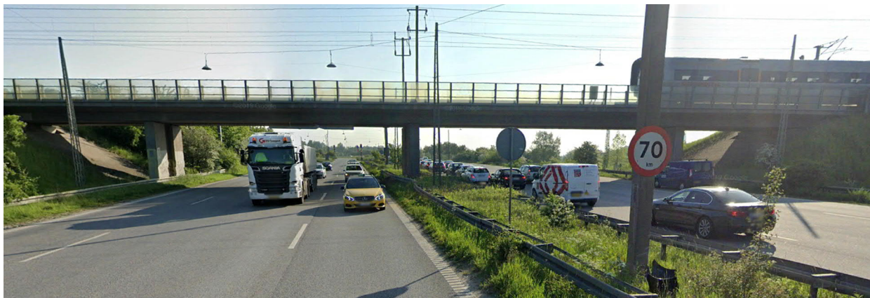
Figur 1 – Bro E10100 Bane over Centrumforbindelsen, facade set mod nordøst
