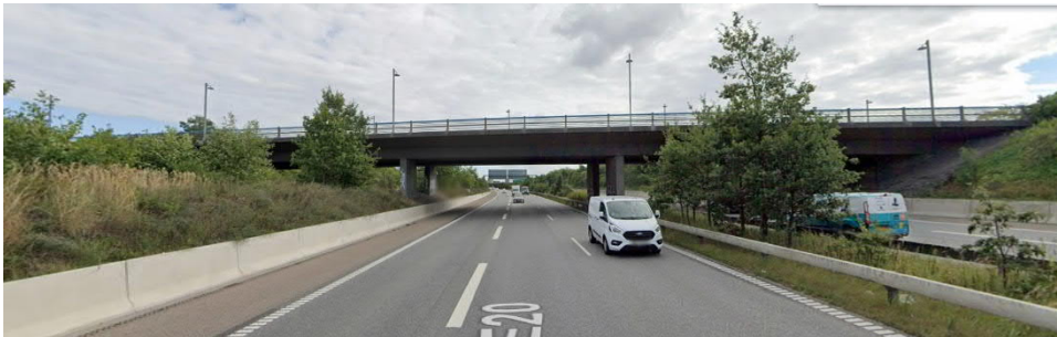
Figur 44: Foto, facade set mod øst.
