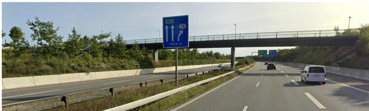
Figur 42 – Bro E10260 Kanalvej, facade set mod øst.
