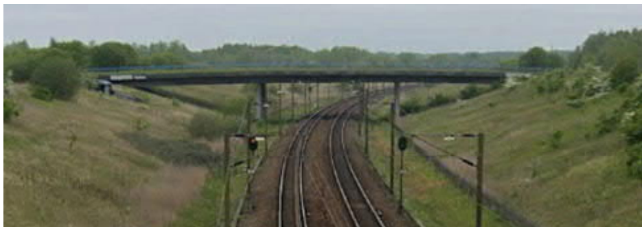
Figur 5 – Bro E10130 Kanonvej, facade set mod vest.
