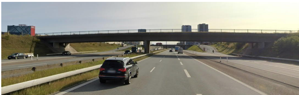
Figur 25: Foto, facade set mod øst.
