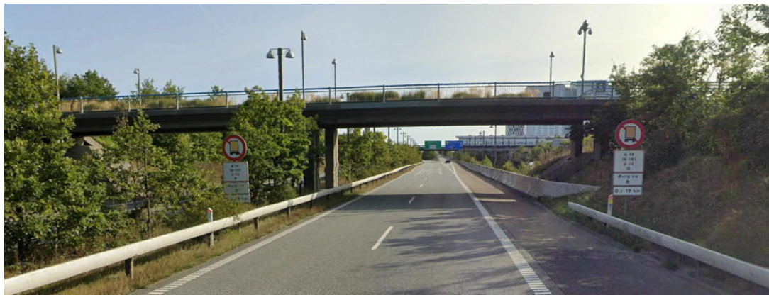
Figur 54 – Bro H10330 Lufthavnsstien, facade set mod øst.
